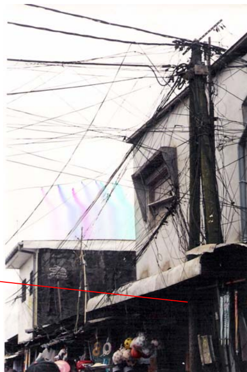
PHOTO 4 : tissu de branchement anarchique, exploitation des poteaux électriques à des fins logistiques et commerciales.
